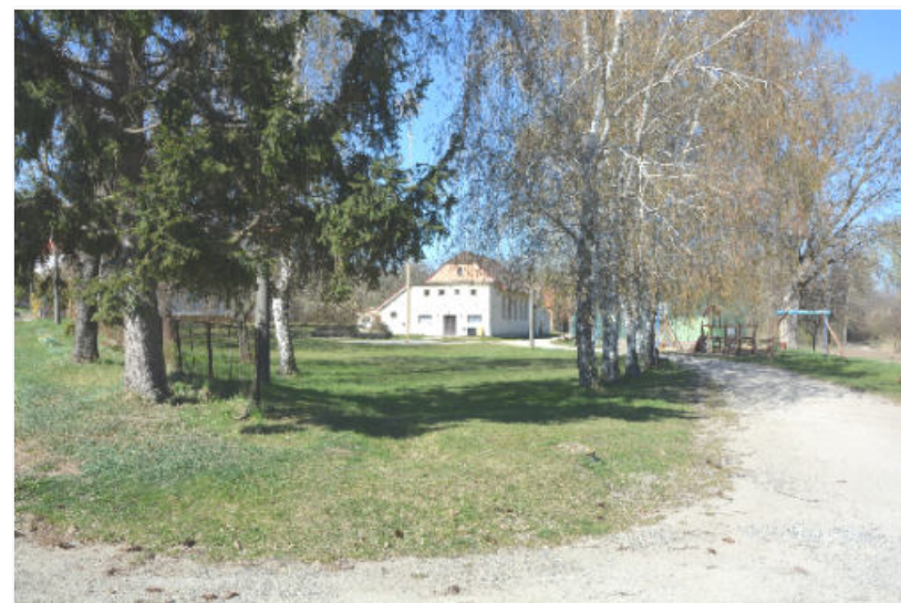
POHLED NA SOKOLOVNU OD SILNICE III/3966
